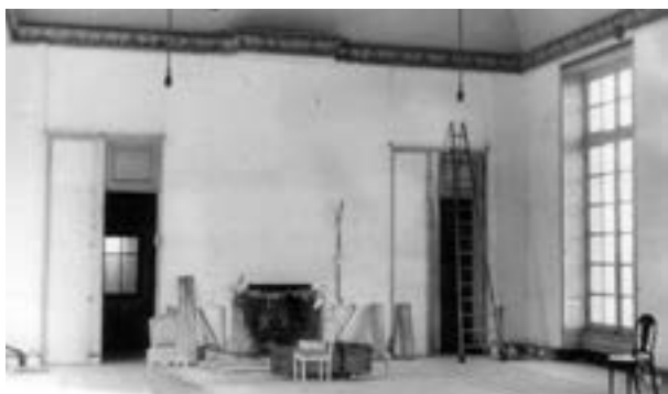
Un salon en cours de rénovation...
